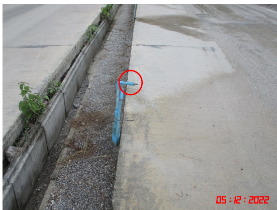
รูปที่ 17 ระบบสเปรย์น้ำล้างล้อรถบรรทุก
