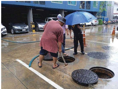
สูบน้ำและกากไขมันระบบบำบัดน้ำเสีย (29/09/65)
