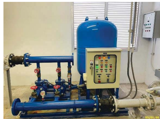
ถังเก็บน้ำสำเร็จรูปชั้นดาดฟ้า พร้อมเครื่องปั้มน้ำ
