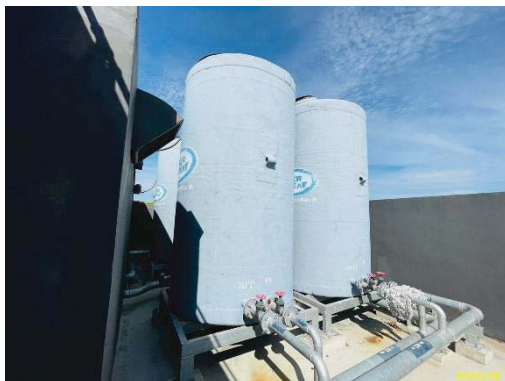
ถังเก็บน้ำสำเร็จรูปชั้นดาดฟ้า พร้อมเครื่องปั้มน้ำ
