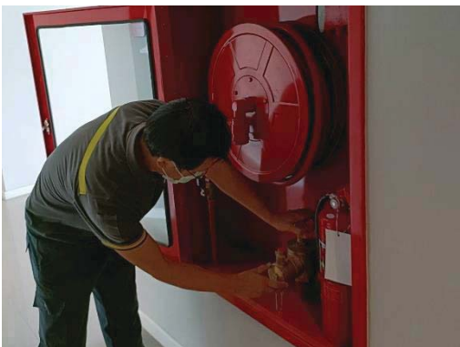
เจ้าหน้าที่ฝ่ายช่างดำเนินการตรวจสอบ และบำรุงรักษาระบบป้องกันและแจ้งเหตุอัคคีภัย
