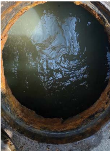
- ปริมาณไขมันในบ่อดักไขมันฝ้าที่6 ก่อนทำการสูบล้าง
