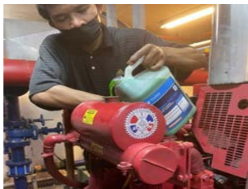
ตรวจเช็คเครื่องปั้มน้ำดับเพลิง
