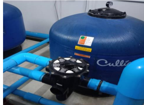
ภาพที่ 2-20 ระบบกรองน้ำในสระว่ายน้ำ
