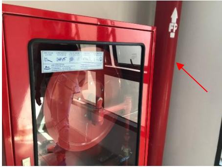
ภาพที่ 2-50 ระบบท่อยืน (Stand Pipe)
