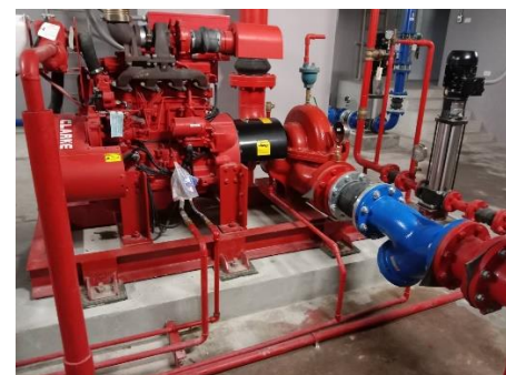
ภาพที่ 2-49 เครื่องสูบน้ำดับเพลิง (Fire Pump)
