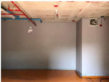
ภาพที่ 2-35 พัดลมดูดอากาศภายในห้องพักมูลพลอย
