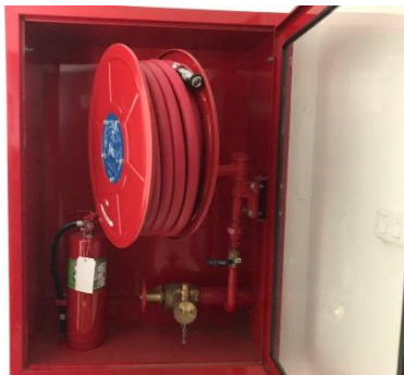
ภาพที่ 2-52 ตู้เก็บสายต่อน้ำดับเพลิงพร้อมอุปกรณ์ (FHC)
