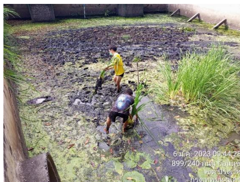
ภาพที่ 2-22 การลอกคลองบำบัดน้ำเสีย
