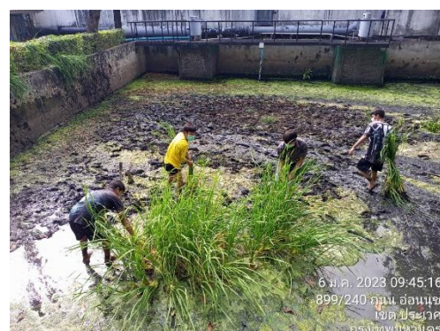
ภาพที่ 2-22 การลอกคลองบำบัดน้ำเสีย
