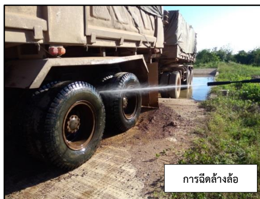
ภาพที่ 2.8 การฉีดล้างล้อรถบรรทุกขนส่งแร่
