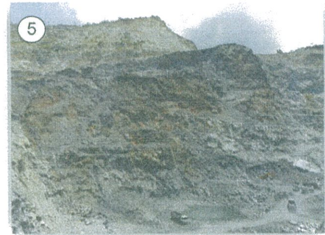
หน้าเหมืองมีลักษณะเป็นชั้นบันได (Bench) มีความสูงหน้าเหมืองไม่เกิน 10 เมตร ความลาดชันรวมไม่เกิน 45 องศา
