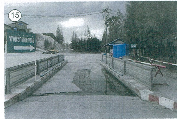
บริเวณบ่อล้างล้อ และแนวต้นไม้ป้องกันฝุ่น
