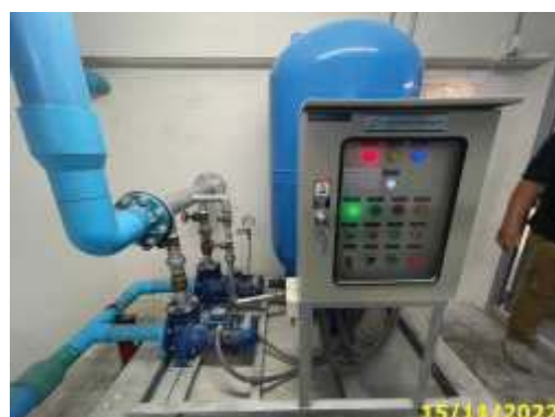
ระบบปั้มน้ำใช้ชั้นดาดฟ้า
