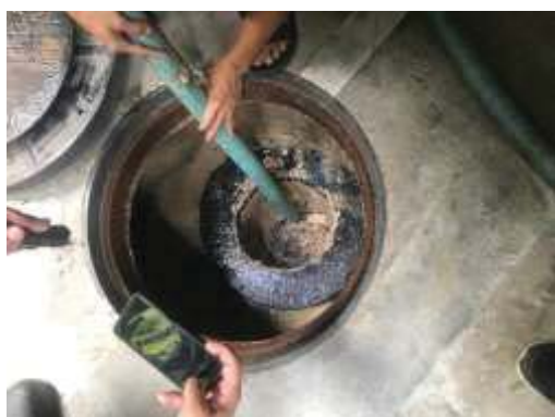
สูบล้างและไขมันระบบบำบัดน้ำเสีย
