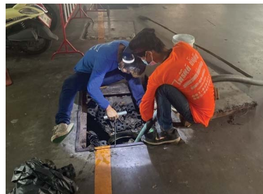
การสูบน้ำตะกอนส่วนเกินระบบบำบัดน้ำเสีย
