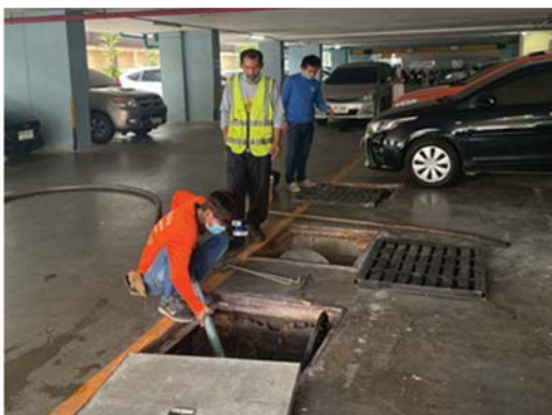
การสูบน้ำตะกอนส่วนเกินระบบบำบัดน้ำเสีย
