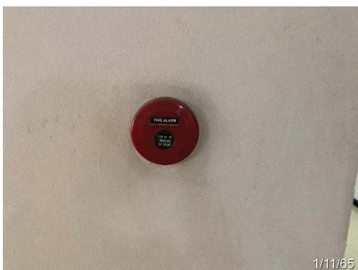
อุปกรณ์แจ้งเหตุเพลิงไหม้โดยใช้อัตโนมัติ
