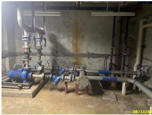
เครื่องสูบน้ำและถังสำรองน้ำชั้นใต้ดิน
