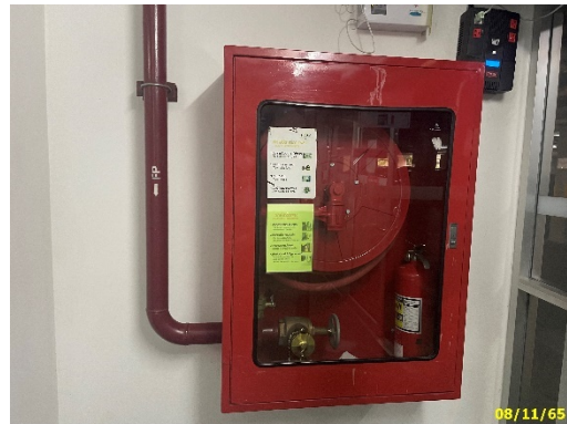
ระบบท่อเย็น และตู้เก็บสายฉีดน้ำดับเพลิงพร้อม อุปกรณ์ (FHC)
