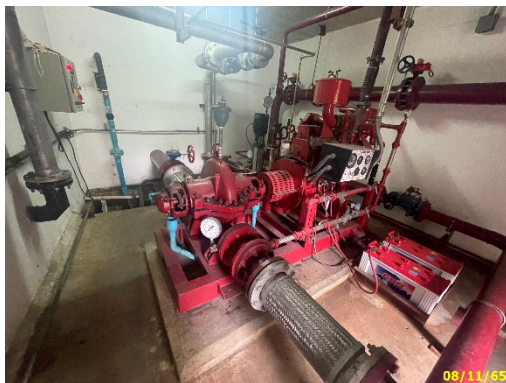
เครื่องสูบน้ำดับเพลิงและตู้ควบคุม
