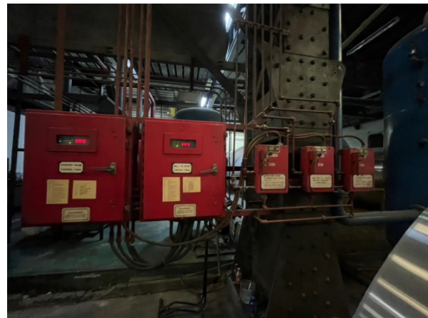
รูปที่ 3-8 แผงควบคุมการทำงานถังเก็บก๊าซ คาร์บอนไดออกไซด์
