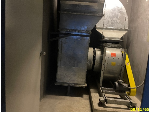
พัดลมระบายอากาศ ชั้นจอดรถใต้ดิน
