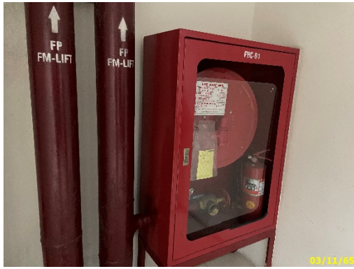
ท่อเย็น และตู้เก็บสายฉีดน้ำดับเพลิง
