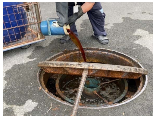
การเติมจุลินทรีย์ในระบบบำบัดน้ำเสีย
