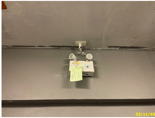
ระบบไฟส่องสว่างฉุกเฉิน
