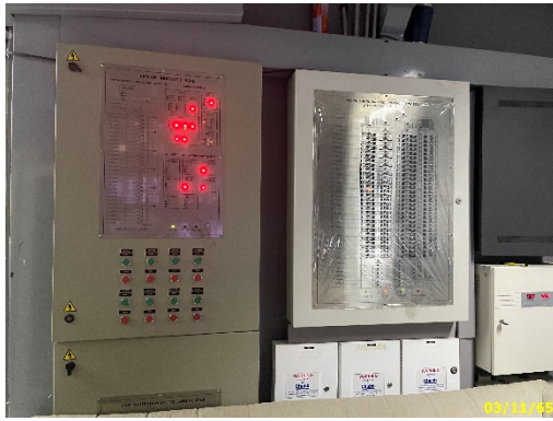
แผงควบคุมระบบสัญญาณแจ้งเหตุ
