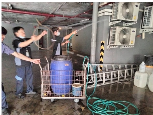
การดูแลความสะอาดเครื่องปรับอากาศส่วนกลาง
