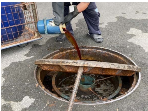
การเติมจุลินทรีย์ในระบบบำบัดน้ำเสีย
