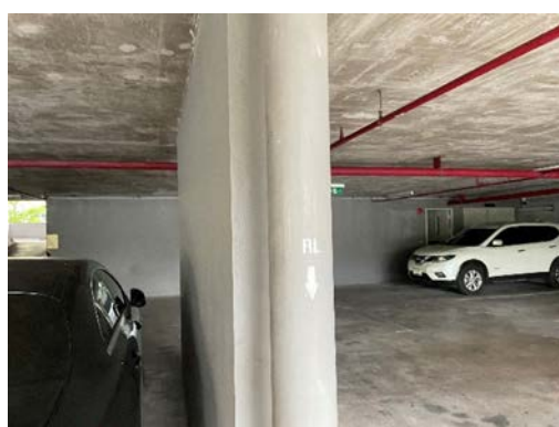
ท่อรวบรวมน้ำเสียและน้ำฝน
