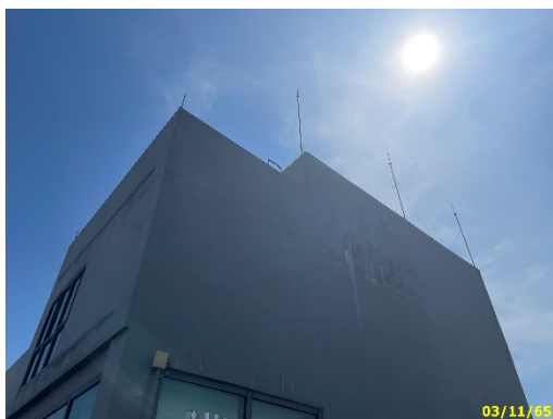
ระบบป้องกันฟ้าผ่า และพื้นที่ตั้งแผงเซลล์ แสงอาทิตย์
