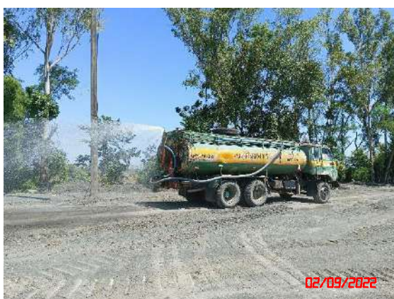
รูปที่ 15 การฉีดพรมน้ำเพื่อลดการฟุ้งกระจายของฝุ่นละออง
