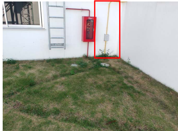
รูปที่ 3-46 ติดตั้งสายดิน
