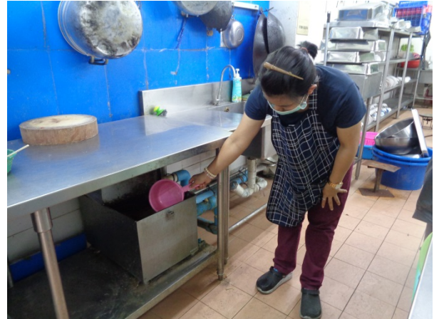
รูปที่ 3-12 พนักงานทำความสะอาดถังดักไขมันออกจากถังดักไขมัน
