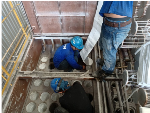
รูปที่ 3-3 การเปลี่ยนถุงกรอง (Bag Filter)
