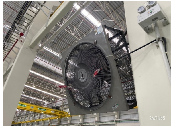
รูปที่ 3-34 พัฒนาระบายอากาศบริเวณพื้นที่เตาหลอม
