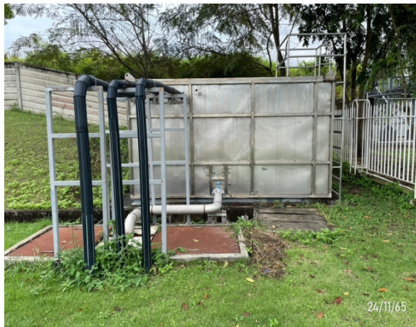
รูปที่ 3-13 บ่อพักน้ำสำหรับระบบบำบัดน้ำเสียทางชีวภาพ
