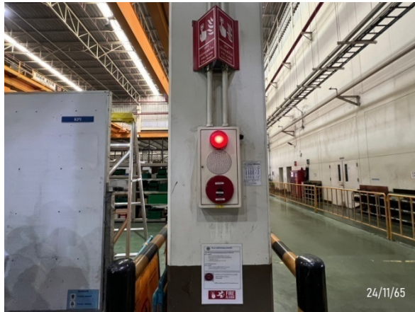
รูปที่ 3-35 (ต่อ) อุปกรณ์ป้องกัน และระงับอัคคีภัย
