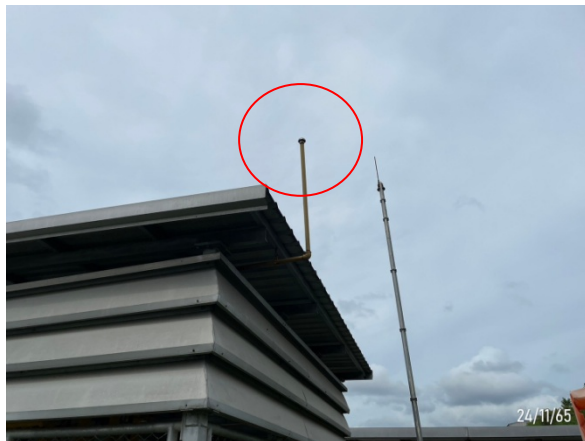
รูปที่ 3-45 ปล่องระบายก๊าซ (Blow Down Stack)
