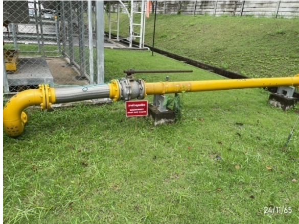
รูปที่ 3-44 วาล์วฉุกเฉิน และลูกศรแสดงทิศทางการไหลของก๊าซ
