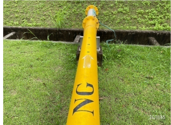
รูปที่ 3-44 วาล์วฉุกเฉิน และลูกศรแสดงทิศทางการไหลของก๊าซ
