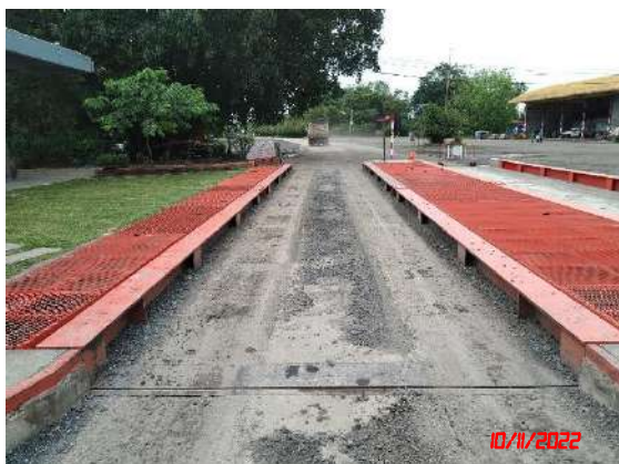
รูปที่ 25 จุดซั้งน้ำหนักรถบรรทุก และป้ายเตือนห้ามบรรทุกเกินน้ำหนักที่กฎหมายกำหนด
