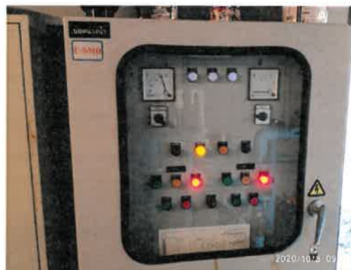
ตู้ควบคุมปั๊มสูบน้ำของบ่อหน่วงน้ำ
