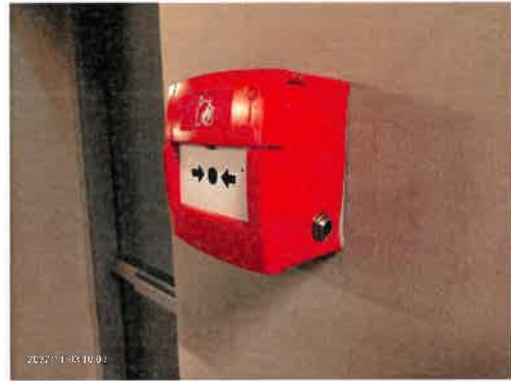
เครื่องแจ้งเหตุโดยใช่มือดึง และช่องเสียบบัตรคีย์ ฉุกเฉิน
