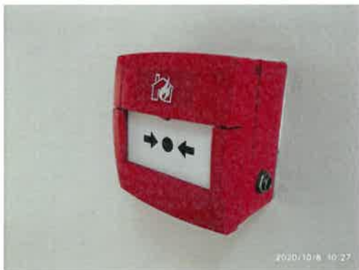
เครื่องแจ้งเหตุโดยใช่มือดึง และช่องเสียบบัตรคิว ฉุกเฉิน
