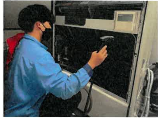
ภาพที่ 2-25 ล้างเครื่องปรับอากาศส่วนกลาง
