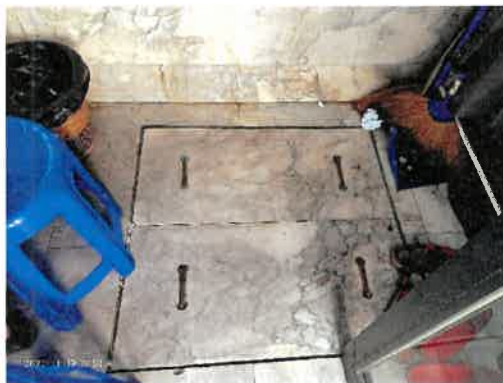
ภาพที่ 2-11 บ่อพักน้ำใส เพื่อติดตามตรวจสอบคุณภาพน้ำทิ้งภายหลังการบำบัด
