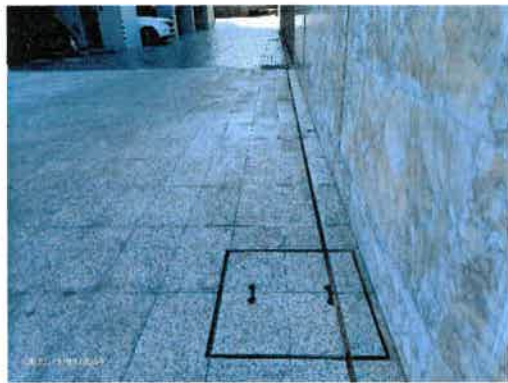
รางรับน้ำฝนเข้าสู่บ่อหน่วยน้ำฝนภายในโครงการ
