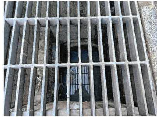
รางรับน้ำฝนเข้าสู่บ่อหน่วยน้ำฝนภายในโครงการ
