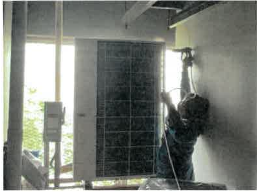
ภาพที่ 2-25 ล้างเครื่องปรับอากาศส่วนกลาง
