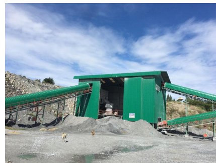
รูปที่ 2-21: การปิดคลุมอาคารโรงโม่
