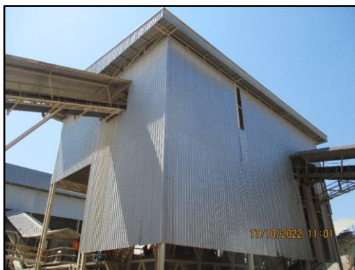
ภาพที่ 2.8 การปิดคลุมเครื่องจักรเป็นระบบปิด
