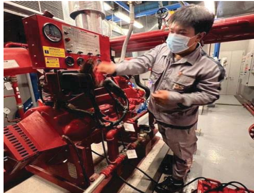
เจ้าหน้าที่ตรวจเช็ค และบำรุงรักษาเครื่องสูบน้ำดับเพลิง
