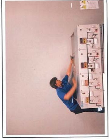
ตรงเจ็ด และบำรุงรักษาส้วมต่างๆ ภายในตู้จ่ายกระแสไฟฟ้าแรงสูง HV Ringmain Unit
