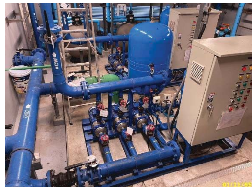
ถังเก็บน้ำชั้นที่ 30 พร้อมเครื่องปั้มน้ำ
