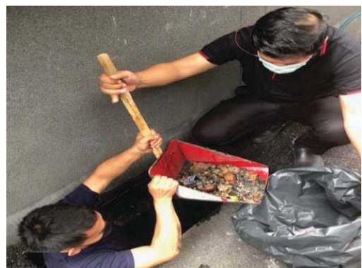
เจ้าหน้าที่ตรวจสอบ และขุดลอกทำความสะอาดท่อระบายน้ำภายในโครงการ
