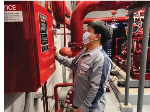
เจ้าหน้าที่ตรวจเช็ค และบำรุงรักษาเครื่องสูบน้ำดับเพลิง
