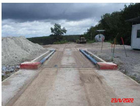
รูปที่ 12 จุดขนั้่น้ำหนักบรรทุกทุกแร่
