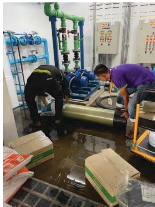
ดำเนินการเปลี่ยนสารกรองน้ำ และไส้กรองน้ำเครื่องกรองน้ำประจำปี 2565
