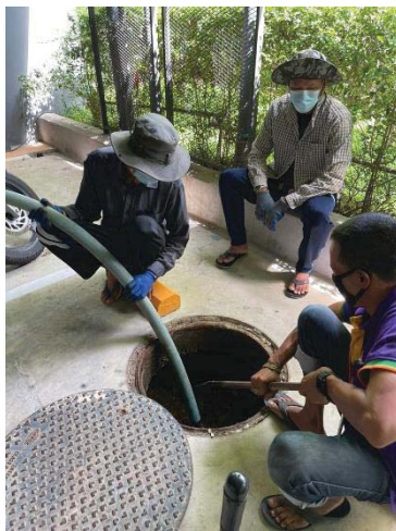
เจ้าหน้าที่ดำเนินการสูบล้างระบบบำบัดน้ำเสีย
