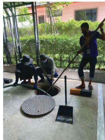
เจ้าหน้าที่ดำเนินการสูบล้างระบบบำบัดน้ำเสีย
