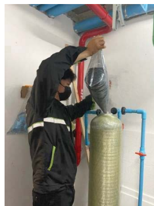
ดำเนินการเปลี่ยนสารกรองน้ำ และใส่กรองน้ำเครื่องกรองน้ำประจำปี
