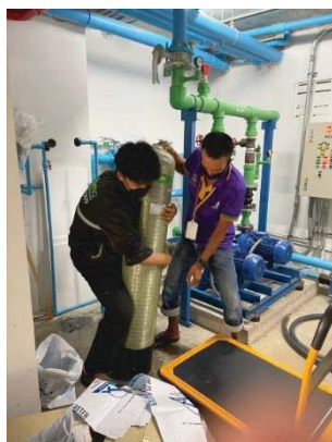
ดำเนินการเปลี่ยนสารกรองน้ำ และใส่กรองน้ำเครื่องกรองน้ำประจำปี
