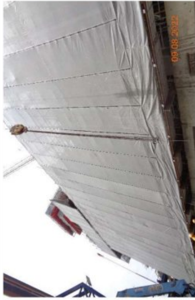
รูปที่ 2-84 Mesh Sheet (แบบกันไฟลาม)
