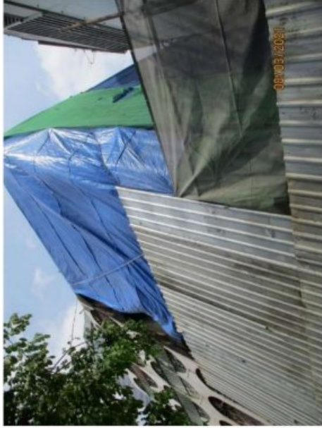
รูปที่ 2-6 แผงป้องกันฝุ่นละอองรอบอาคารรื้อถอน
