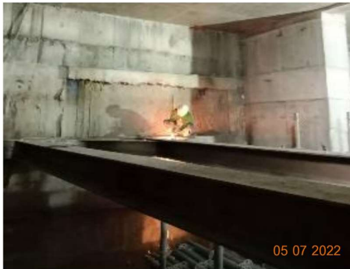
งานรื้อ Bracing ชั้น B1
