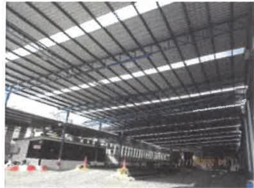
รูปที่ 2-7 ระบบระบายอากาศบนหลังคาของโกดังพักสินค้า
