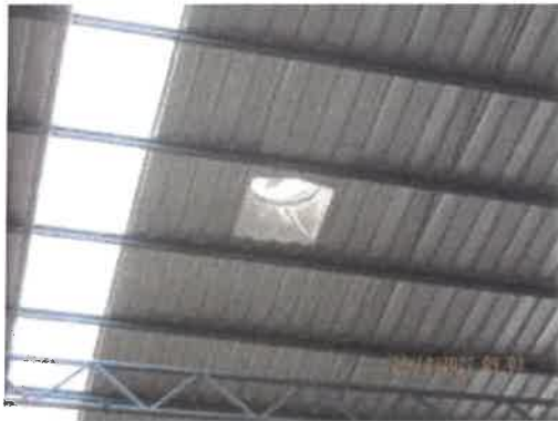
รูปที่ 2-7 ระบบระบายอากาศบนหลังคาของโกดังพักสินค้า
