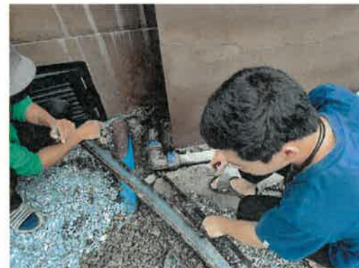
เจ้าหน้าที่ซ่อมบำรุงเส้นท่อ ภาพที่ 2.2-5 (ต่อ) ระบบน้ำใช้
