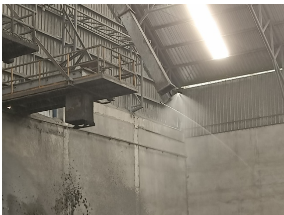
รูปที่ 2-15 ระบบฉีดพรมภายในอาคารเก็บแฉะ
