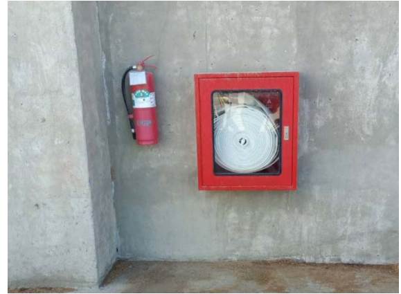
หัวดับเพลิงและสายฉีดน้ำดับเพลิง
