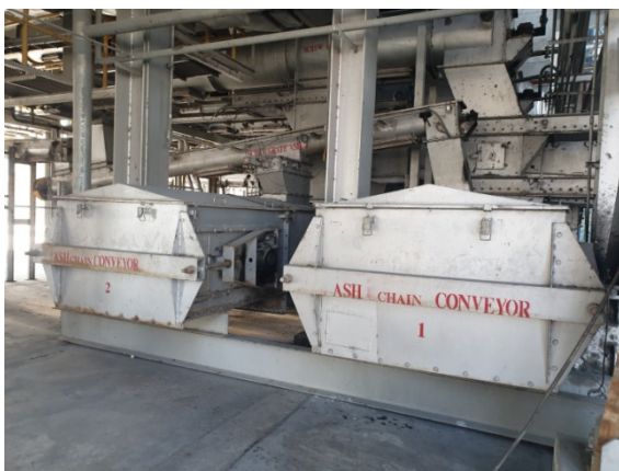
รูปที่ 2-28 ระบบลำเลียงเถ้าจากห้องเผาไหม้หม้อไอน้ำมีการปิดครอบมิดชิด
