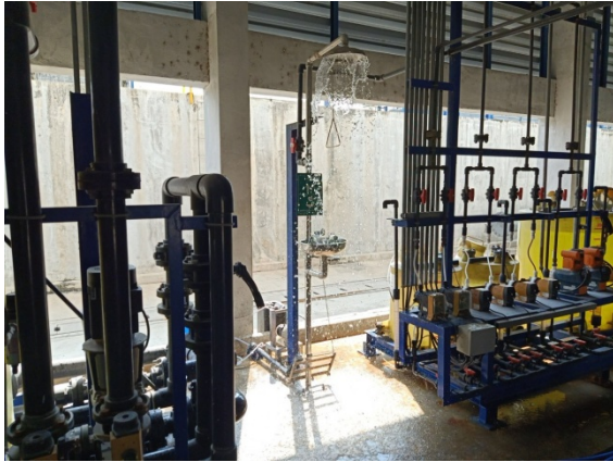
รูปที่ 2-42 อุปกรณ์ฉุกเฉิน ได้แก่ อ่างล้างตา และฝักบัวฉุกเฉิน
