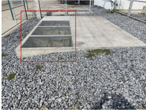
รูปที่ 2-17 เครื่องแยกน้ำมัน (Oil Separator)
