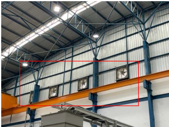
รูปที่ 2-49 ระบบระบายอากาศ
