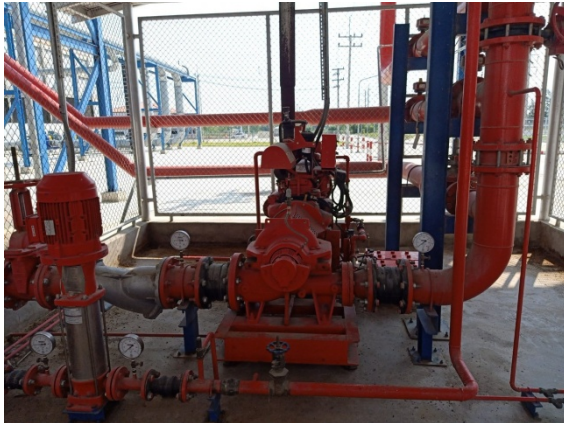
รูปที่ 2-54 เครื่องสูบน้ำดับเพลิง (Fire pump)
