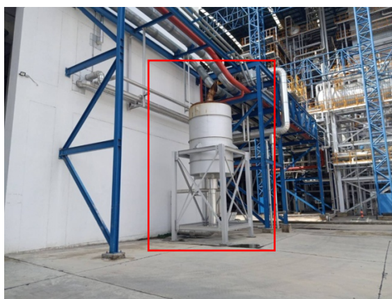
รูปที่ 2-9 ติดตั้งอุปกรณ์ป้องกันเสียงดัง (Silencer)
