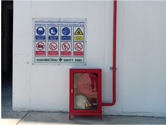
หัวดับเพลิงและสายฉีดน้ำดับเพลิง
