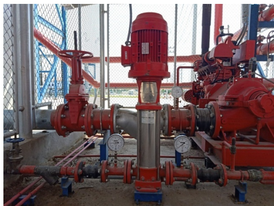
รูปที่ 2-55 เครื่องสูบน้ำรักษาแรงดัน (Jockey pump)
