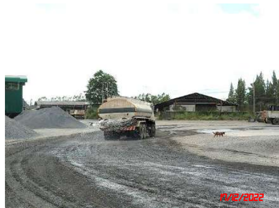
รูปที่ 16 การฉีดพรมน้ำเพื่อลดการฟุ้งกระจายของฝุ่นละออง
