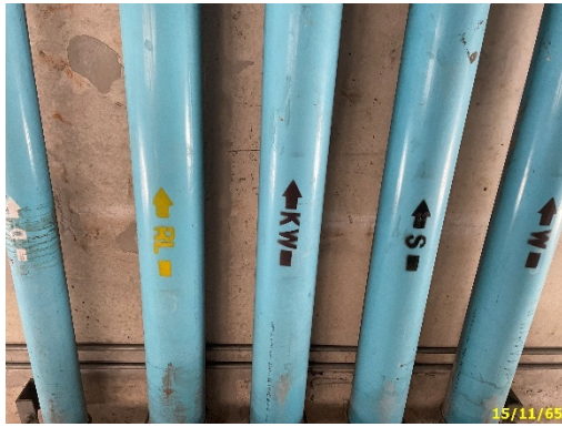
ระบบระบายน้ำฝนจากหลังคา และระบายน้ำ ภายในอาคาร
