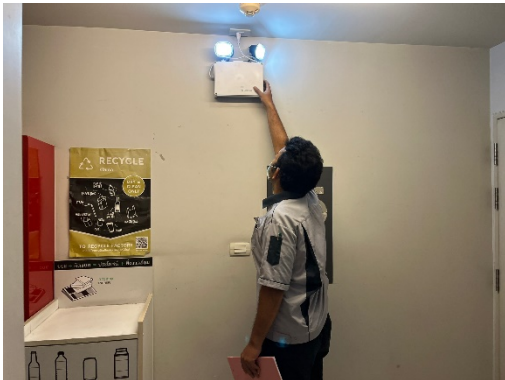
ดูแลตรวจสอบระบบไฟฉุกเฉิน
