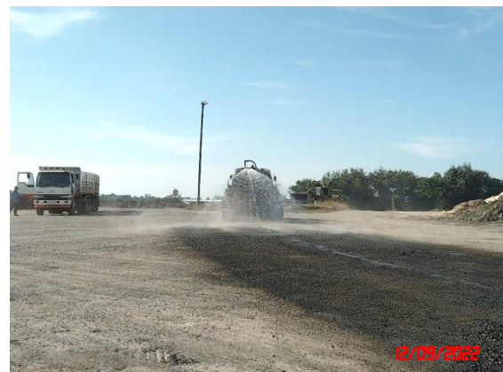
รูปที่ 9 การฉีดพรมน้ำป้องกันการฟุ้งกระจายของฝุ่นละออง
