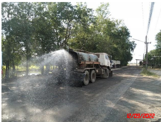
รูปที่ 9 การฉีดพรมน้ำป้องกันการฟุ้งกระจายของฝุ่นละออง
