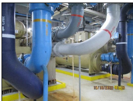
รูปที่ 2-18 เครื่องทำความเย็นชนิดระบายความร้อนด้วยน้ำแบบหอยโข่งและแบบสกรู
