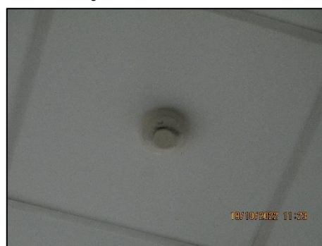
อุปกรณ์ตรวจจับควันและความร้อน
