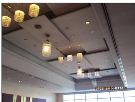
รูปที่ 2-20 การติดตั้งระบบแสงสว่างภายในอาคารไม่สูงกว่า 16 วัดต่อตารางเมตร
