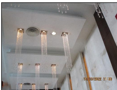
รูปที่ 2-20 การติดตั้งระบบแสงสว่างภายในอาคารไม่สูงกว่า 16 วัดต่อตารางเมตร
