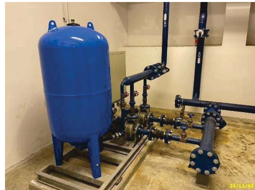
ถังเก็บน้ำชั้นดาดฟ้า พร้อมเครื่องสูบน้ำแรงดันสูง
