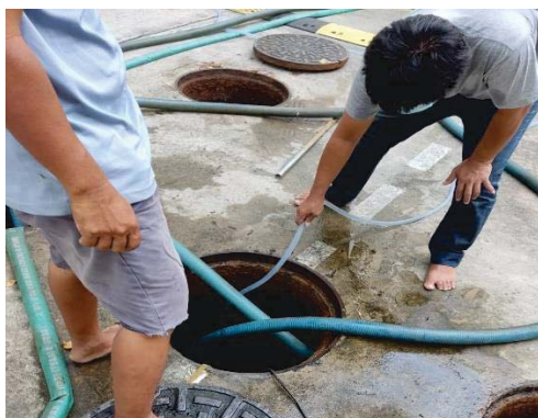
สูบน้ำจากระบบบำบัดน้ำเสีย
