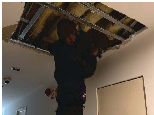
เจ้าหน้าที่ฝ่ายช่างดำเนินการตรวจสอบ และซ่อมแซมระบบประปา
