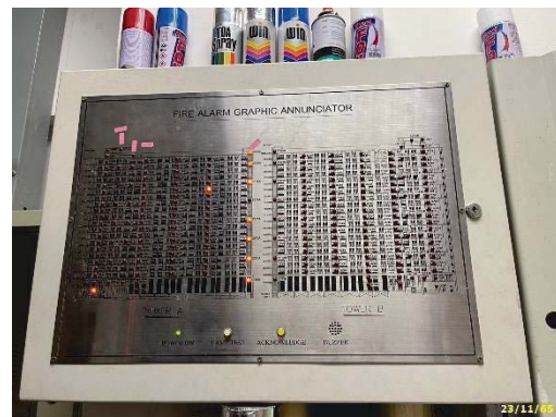
แผงแสดงสัญญาณพื้นที่ที่เกิดเหตุเพลิงไหม้
