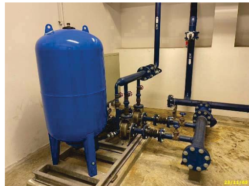
ถังเก็บน้ำขึ้นคาตฟ้า พร้อมเครื่องสูบน้ำ
