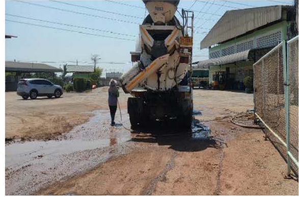
ภาพที่ 3.4 พื้นที่ล้างตัวรถและล้อรถ
