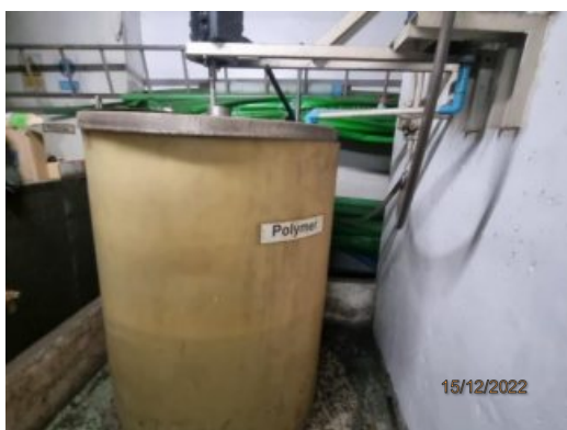
(7) เครื่องเติมสารโพลิเมอร์ (Polymer Feed)
