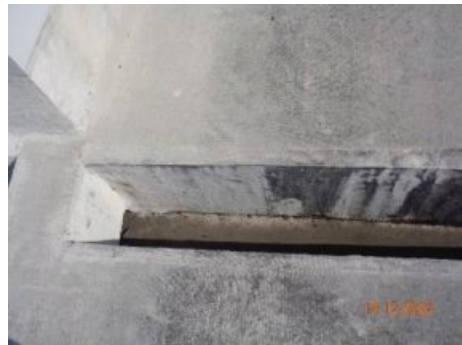
(2) รางระบายน้ำฝนบนดาดฟ้าของอาคาร
