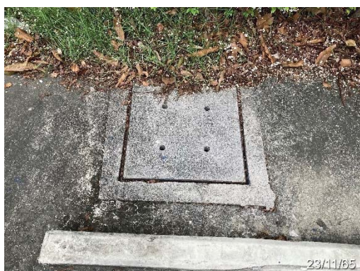
บ่อดักน้ำและท่อระบายน้ำนอกอาคาร
