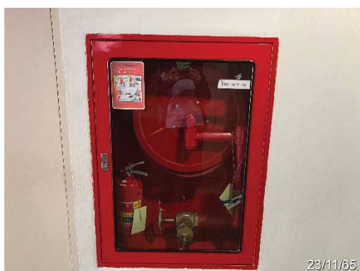
ตู้เก็บสายฉีดน้ำดับเพลิงและอุปกรณ์
