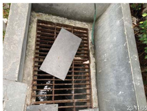
บ่อดักน้ำพร้อมตะแกรงดักขยะ
