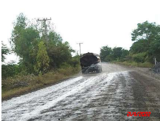
รูปที่ 18 การฉีดพรมน้ำเพื่อลดการฟุ้งกระจายของฝุ่นละออง
