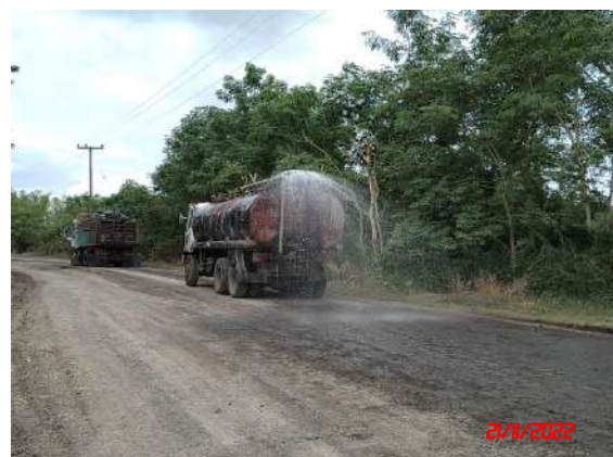
รูปที่ 18 การฉีดพรมน้ำเพื่อลดการฟุ้งกระจายของฝุ่นละออง
