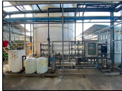
ภาพที่ 3.15 ระบบปรับปรุงคุณภาพน้ำทิ้งแบบอาร์โอ
