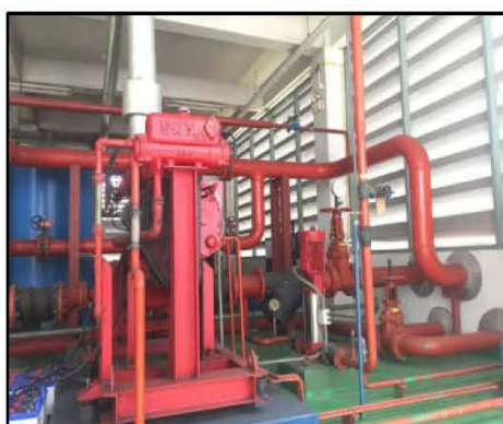
ภาพที่ 3.42 เครื่องสูบน้ำดับเพลิง
