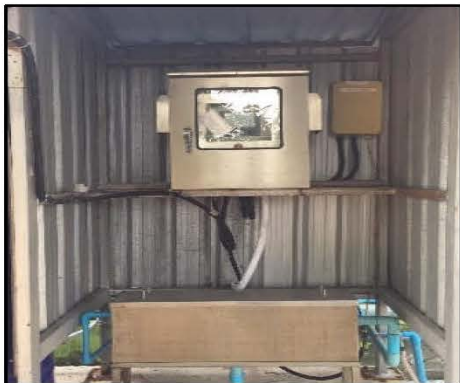
ภาพที่ 3.16 เครื่องวัด BOD/COD แบบต่อเนื่อง
