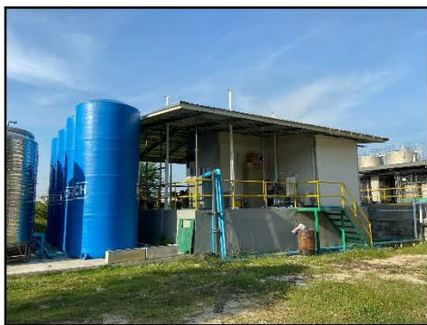
ภาพที่ 3.13 บ่อพักน้ำเสียฉุกเฉินขนาด 160 ลูกบาศก์เมตร
