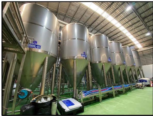
ภาพที่ 3.1 ถังหมัก/บ่มเพื่อผลิตเปียร์ ของโครงการที่มีการปิดมิดชิด
