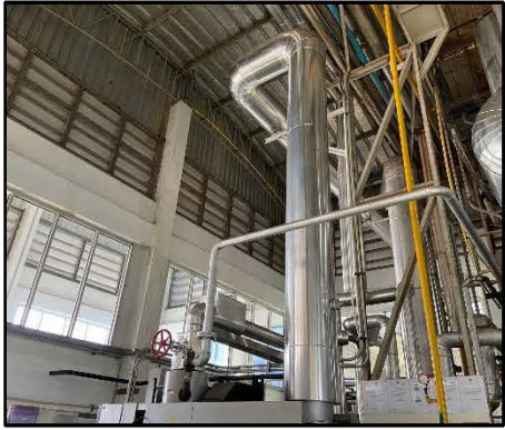
ภาพที่ 3.8 ฉนวนกันความร้อนและเสียงที่ระบบท่อ ของระบบวาล์วควบคุมความดันเกิน
