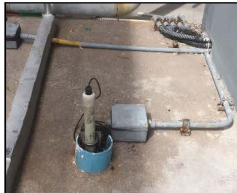
ภาพที่ 3.17 อุปกรณ์ตรวจวัดคุณภาพน้ำแบบอัตโนมัติ (ตรวจวัดพีเอช และค่าการนำไฟฟ้า)
