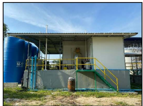
ภาพที่ 3.13 บ่อพักน้ำเสียฉุกเฉินขนาด 160 ลูกบาศก์เมตร
