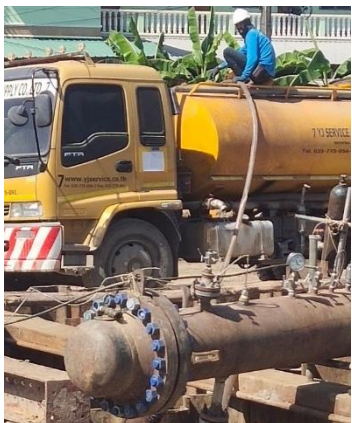
การเติมน้ำประปาลงในท่อที่จะทดสอบและเพิ่มความดันในท่อทิ้งไว้ 24 ชั่วโมง
