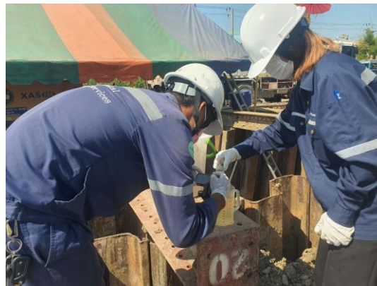
การเก็บตัวอย่างน้ำจากการทดสอบ เมื่อดำเนินการทดสอบท่อแล้วเสร็จ
