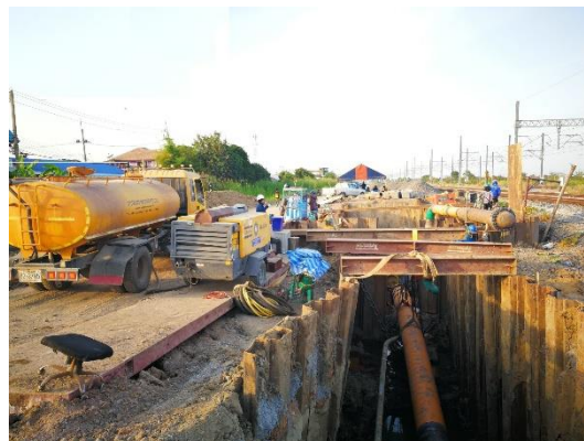
การเติมน้ำประปาลงในท่อที่จะทดสอบและเพิ่มความดันในท่อทิ้งไว้ 24 ชั่วโมง
