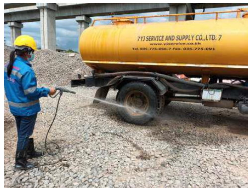
ภาพที่ 3-12 : พื้นที่ฉีดล้างทำความสะอาดล้อรถภายในพื้นที่เก็บกองท่อ (Stock Yard)
