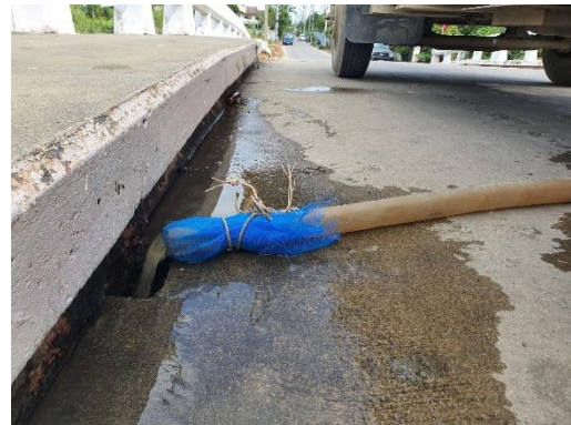
การระบายน้ำทิ้งจากการทดสอบท่อลงสู่คลองเปรมประชากรเมื่อทราบผลการวิเคราะห์คุณภาพน้ำ
