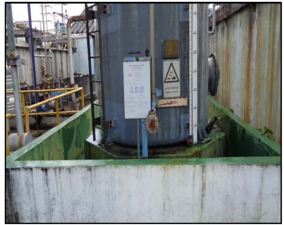
ภาพถ่ายที่ 50 คันคอนกรีตกำหนด ขอบเขตการเก็บสารเคมี
