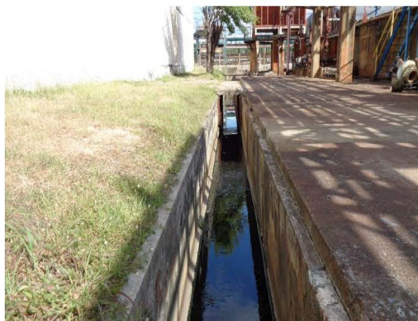
ภาพถ่ายที่ 4 รางระบายน้ำฝนของโครงการ
