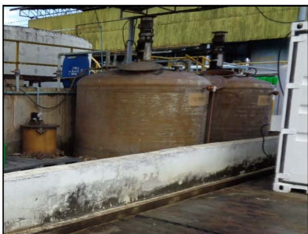
ภาพถ่ายที่ 5 คันคอนกรีตกัน (Bund) บริเวณลานถังเก็บวัตถุดิบและสารเคมี
