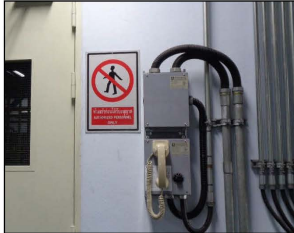
ภาพถ่ายที่ 73 ระบบ Acoustic Alarm
