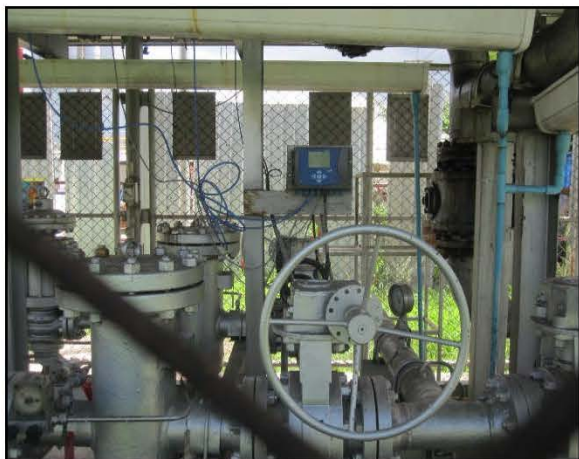
ภาพถ่ายที่ 61 เครื่องตรวจจับก๊าซไวไฟ (Flammable Gas Detector)
