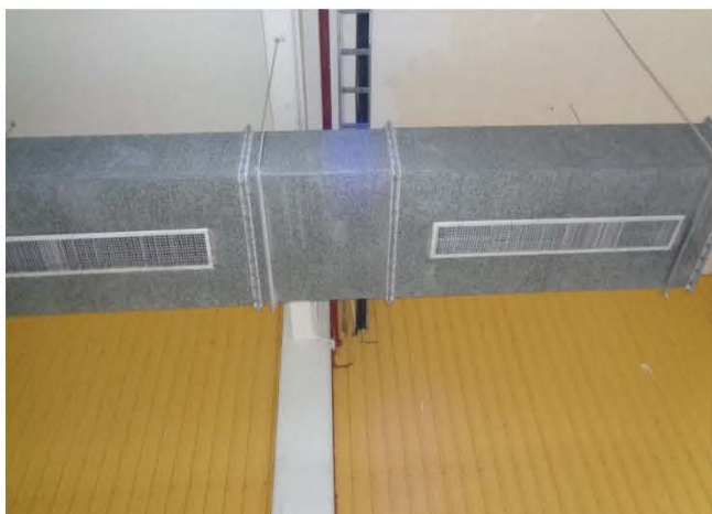
ภาพถ่ายที่ 43 ระบบระบายอากาศเพื่อลดอุณหภูมิ ภายในพื้นที่ส่วนผลิตที่มีความร้อนสูง
