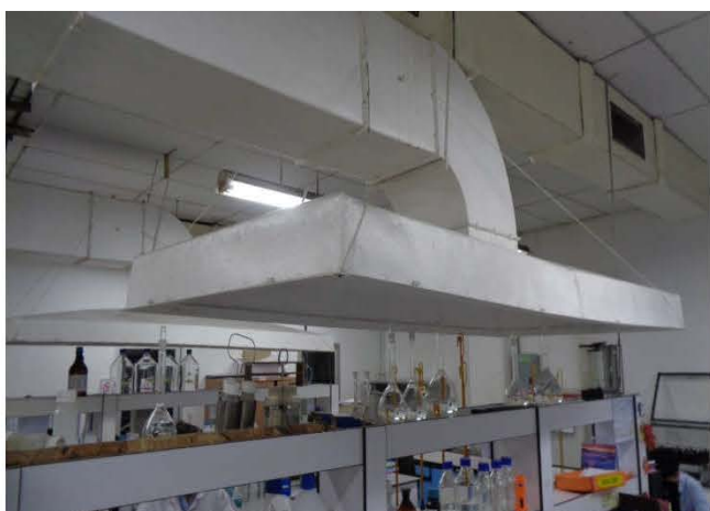
ภาพถ่ายที่ 45 ระบบดูดควันในห้องปฏิบัติการ
