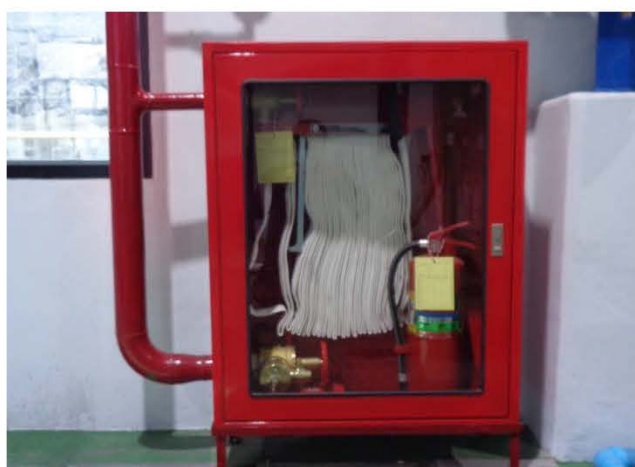
ภาพถ่ายที่ 41 ตู้เก็บสายฉีดน้ำดับเพลิง (Fire Hose)
