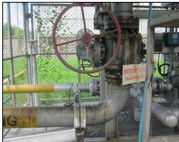
ภาพถ่ายที่ 62 วาล์วตัดแยกระบบ บริเวณสถานีควบคุมก๊าซ (Metering Station)
