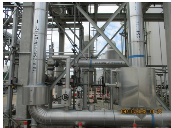
รูปที่ 3.1-2(49) อุปกรณ์วัดความดันบริเวณแนวท่อขนส่ง
