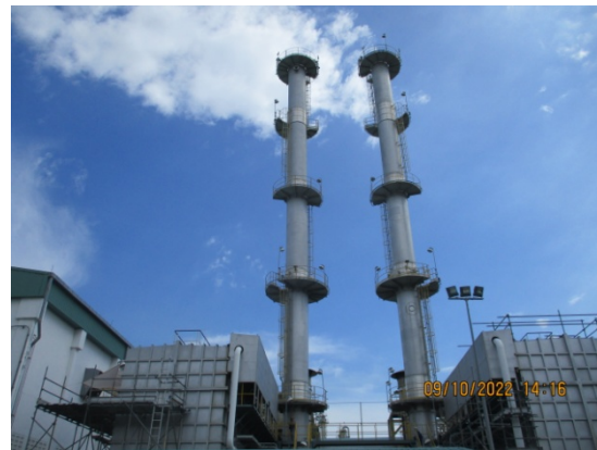
รูปที่ 3.1-2(2) ปล่องระบาย RTO หน่วยที่ 1 และหน่วยที่ 2
