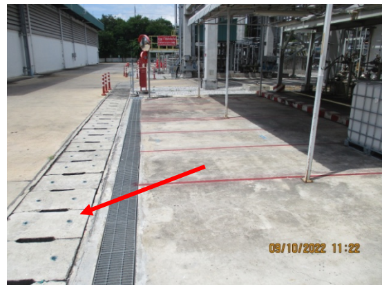
รูปที่ 3.1-2(16) ร่องระบายน้ำฝนที่แยกออกจากร่องระบายน้ำของกระบวนการผลิต
