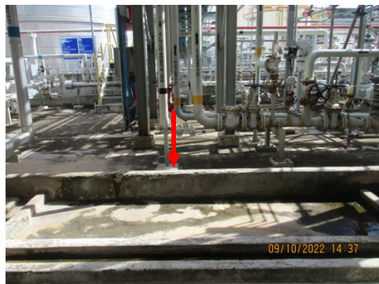
รูปที่ 3.1-2(41) คั่นกันบริเวณเครื่องสูบลำย สารเคมี
