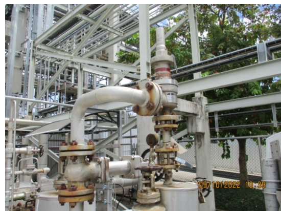
รูปที่ 3.1-2(50) วาล์วนิรภัยบริเวณแนวท่อขนส่ง
