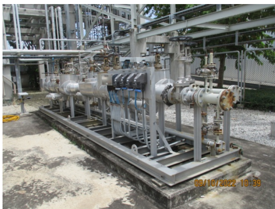
รูปที่ 3.1-2(50) วาล์วนิรภัยบริเวณแนวท่อขนส่ง
