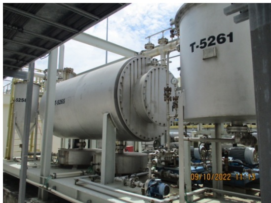
รูปที่ 3.1-2(7) ระบบบำบัดอากาศ บริเวณระบบบำบัดน้ำเสีย
