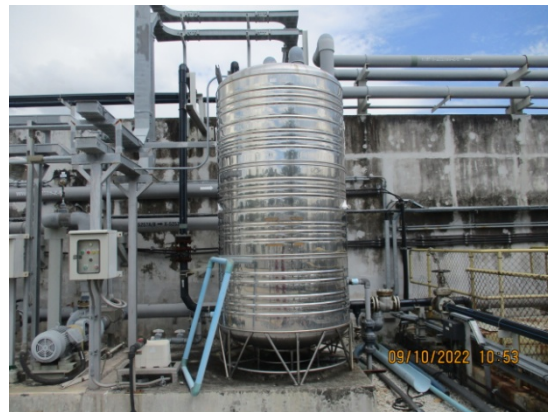
รูปที่ 3.1-2(19) การติดตั้งอุปกรณ์เพื่อนำน้ำที่บำบัดแล้วกลับมารดน้ำต้นไม้
