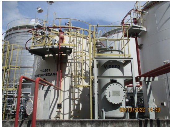
รูปที่ 3.1-2(5) หอดูดซับด้วยถ่านกัมมันต์ (Activated Carbon Adsorber)
