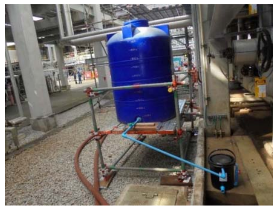
รูปที่ 3.1-1(7) ถังกรองทรายหรือ บ่อรองรับน้ำเสีย
