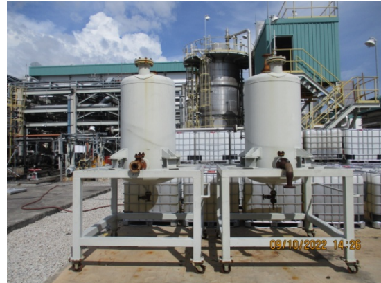
รูปที่ 3.1-2(6) หอดูดซับด้วยถ่านกัมมันต์สำรอง (Stand By)
