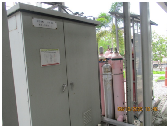
รูปที่ 3.1-2(3) ระบบ CEMs DFTO หน่วยที่ 1 และหน่วยที่ 2
