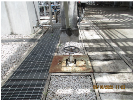
รูปที่ 3.1-2(16) ร่องระบายน้ำฝนที่แยกออกจากร่องระบายน้ำของกระบวนการผลิต
