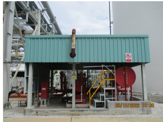
เครื่องสูบน้ำดับเพลิงชนิดเครื่องยนต์ดีเซล (Diesel Engine Pump)
