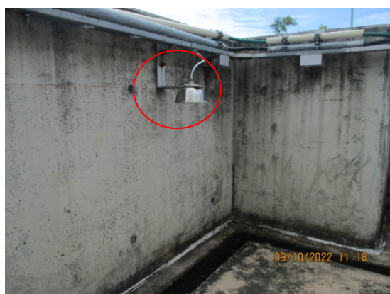
รูปที่ 3.1-2(9) Gas Detector
