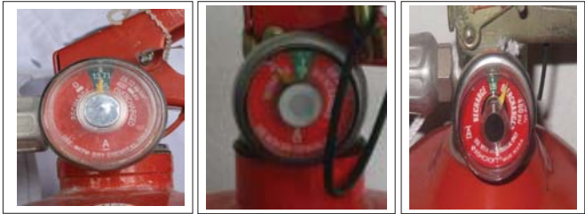
รูปที่ 3.4 ถังดับเพลิงที่พร้อมใช้งาน รูปที่ 3.5 ถังดับเพลิงที่กำลังดันตก รูปที่ 3.6 ถังดับเพลิงที่แรงดันสูงเกิน
