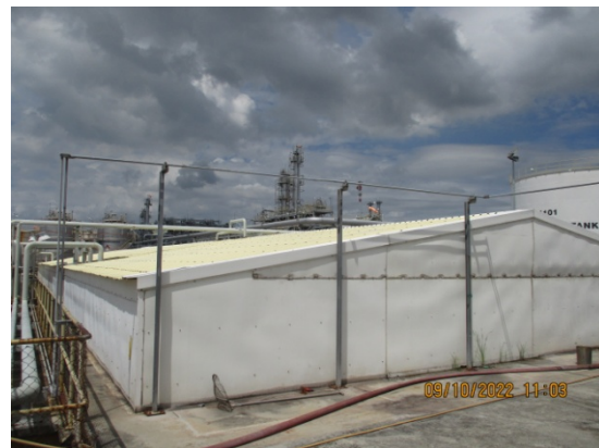
รูปที่ 3.1-2(8) การปิดคลุมบ่อรวบรวมน้ำเสีย
