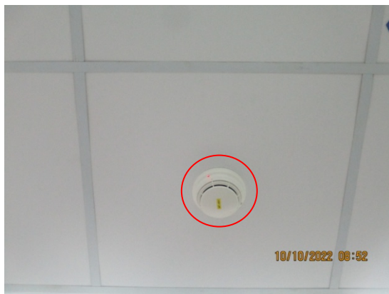
รูปที่ 3.1-2(30) Smoke Detector
