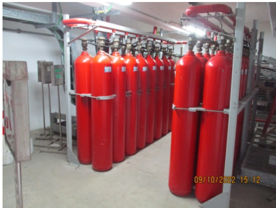
ระบบก๊าซคาร์บอนไดออกไซด์ (CO 2 )
