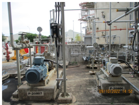
รูปที่ 3.1-2(51) Indicator วัดความดันบริเวณปั๊ม เครื่องกวน หรือปะเก็น
