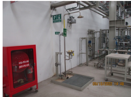
รูปที่ 3.1-2(27) อ่างล้างตาและฝักบัวล้างตัว
