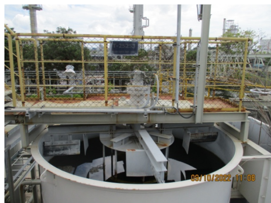
บ่อดักตะกอนแบบ High-rate DAF
