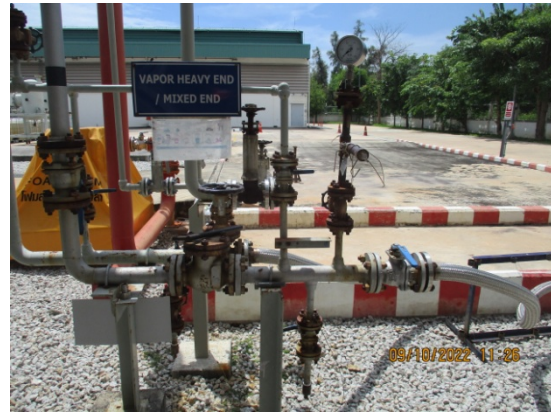
รูปที่ 3.1-2(44) อุปกรณ์ตรวจสอบการรั่วไหลที่แนวท่อขนส่ง
