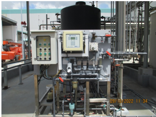
รูปที่ 3.1-2(55) Conductivity Online ที่น้ำระบายทิ้งจากระบบผลิตน้ำหล่อเย็น
