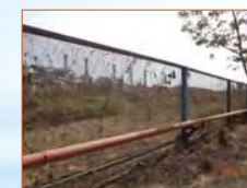
โครงสร้างเหล็กติดตั้งตาข่ายดักฝุ่นล้อมรอบพื้นที่ลานกองแฉะ
