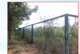
โครงเหล็กติดตาข่ายตักฝุ่นล้อมรอบพื้นที่ลานกองเถ้า
