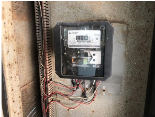
รูปที่ 5 มิเตอร์ตรวจวัดไฟฟ้า
