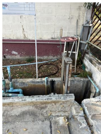
รูปที่ 2 รางระบายน้ำฝนของโรงงานในนิคมฯ
