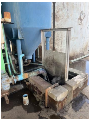
รูปที่ 7 บ่อพักน้ำทิ้งหลังการบำบัดของโรงงานในนิคมฯ
