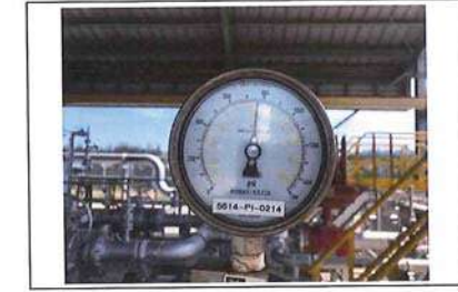
ความดันก๊าซก่อนเข้าอุปกรณ์ปรับลดแรงดัน
