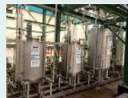
ถังสารเคมีที่ Chemical Dosing Skid
