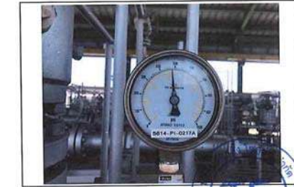
ความดันก๊าซหลังอุปกรณ์ปรับลดแรงดัน
