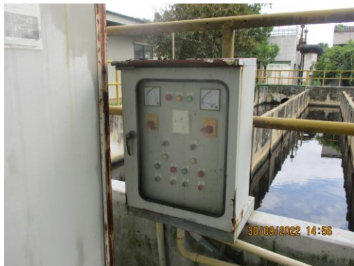
รูปที่ 6 อุปกรณ์ตรวจวัดคุณภาพน้ำ Online ได้แก่ pH, SS, BOD, และ COD
