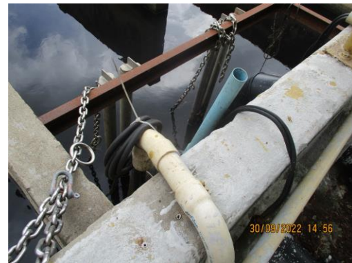
รูปที่ 6 อุปกรณ์ตรวจวัดคุณภาพน้ำ Online ได้แก่ pH, SS, BOD, และ COD
