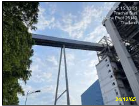
รูปที่ 2-6 ระบบสายพานลำเลียงเชื้อเพลิงชีวมวล
