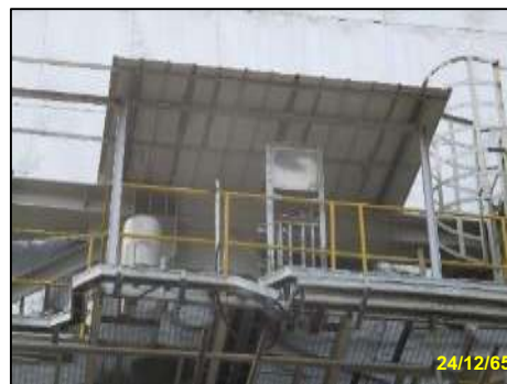
รูปที่ 2-2 ตำแหน่งที่ติดตั้งเครื่องตรวจวัดความเข้มข้นของมลพิษทางอากาศจากปล่องแบบอัตโนมัติอย่างต่อเนื่อง (CEMs)
