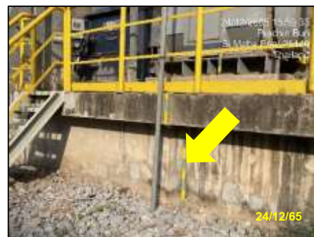
รูปที่ 2-51 สายดินบริเวณเตาเผาไหม้และปากไซโล
