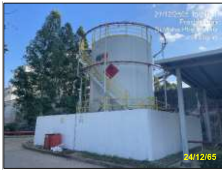
รูปที่ 2-14 คั่นคอนกรีตล้อมรอบลานถังน้ำมันดีเซล
