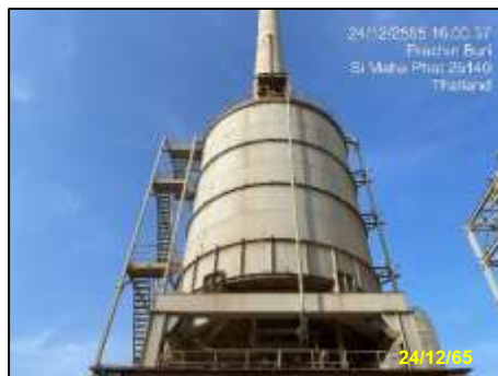
รูปที่ 2-28 ถังเก็บเถ้าลอย (Fly Ash Silo)
