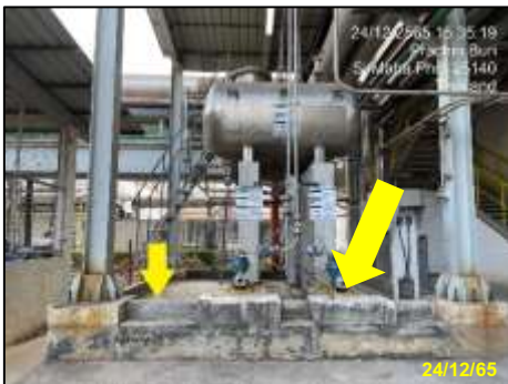
รูปที่ 2-39 เชื้อเพลิงป้องกันการรั่วไหลรอบถังบรรจุสารเคมี
