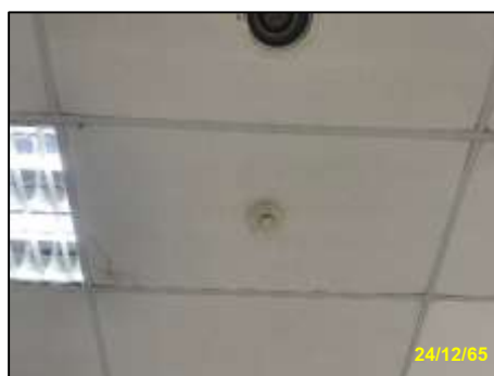
รูปที่ 2-44 อุปกรณ์ตรวจจับควัน
