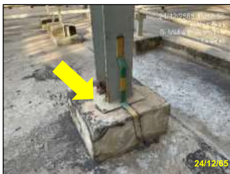
รูปที่ 2-51 สายดินบริเวณเตาเผาไหม้และปากไซโล
