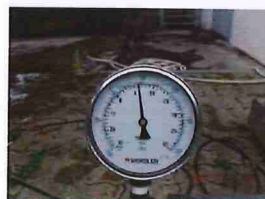
รูปที่ 3 Suction Pressure ที่อ่านค่าได้เท่ากับ 6 psi.
