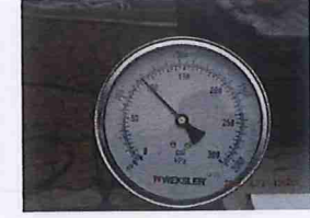
รูปที่ 28 Discharge Pressure ที่อ่านค่าได้เท่ากับ 100 psi.
