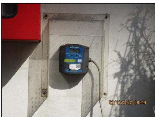
ภาพที่ 2.28 อุปกรณ์ตรวจจับและระงับเหตุคลอรีนรั่วไหล
