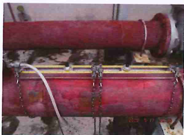
รูปที่ ๑ การติดตั้งเซ็นเซอร์ (Sensor) ขงเครื่องมือวัดอัตราการไหลของน้ำ (Flow Rate) ภายในเส้นท่อน้ำดับเพลิง
