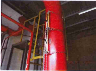
รูปที่ 1 การติดตั้งเซ็นเซอร์ (Sensor) ของเครื่องวัดอัตราการไหลของน้ำ (Flow Rate) ภายในเส้นท่อน้ำดับเพลิง
