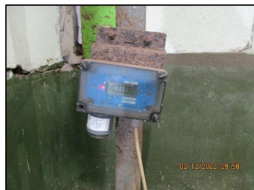
ภาพที่ 2.28 อุปกรณ์ตรวจจับและระงับเหตุคลอรีนรั่วไหล
