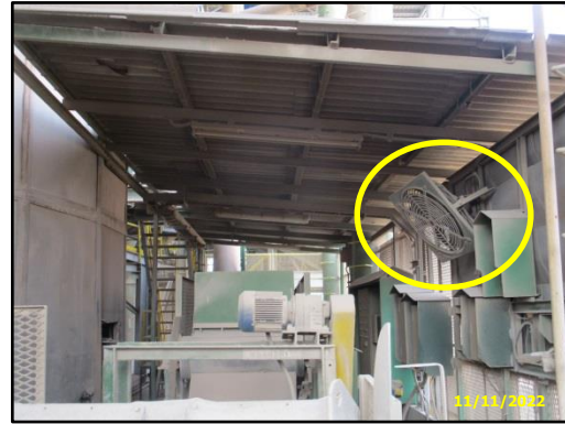
ภาพที่ 2.44 การติดตั้งพัดลมระบายอากาศ
