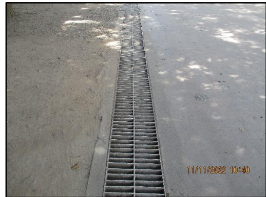
ภาพที่ 2.10 ตะแกรงดักขยะบริเวณรางระบายน้ำทิ้ง
