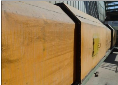
ภาพที่ 3.102 อาคารปิดคลุมเพื่อป้องกันเสียงออกสู่ภายนอกบริเวณอาคารหม้ออบซีเมนต์และติดตั้งวัสดุ ป้องกัน/ลดระดับเสียงดัง Casing ทุ้มชุด Hammering Equipment
