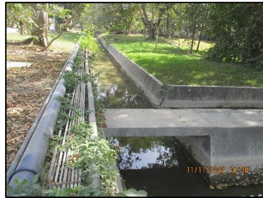
ภาพที่ 2.13 บ่อดักไขมันก่อนที่จะไหลลงสู่บ่อตกตะกอน
