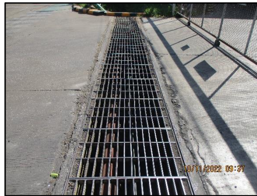
ภาพที่ 2.12 ตะแกรงดักขยะและบ่อดักไขมันที่บริเวณถังเก็บ Liquid Waste
