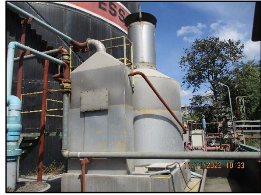
ภาพที่ 2.8 ระบบรวบรวมและกำจัดไอของเสีย บริเวณถังเก็บน้ำมันเตาเดิม
