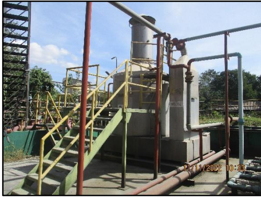
ภาพที่ 2.8 ระบบรวบรวมและกำจัดไอของเสีย บริเวณถังเก็บน้ำมันเตาเดิม
