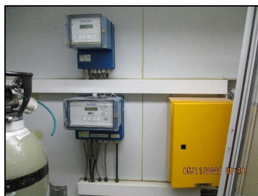
ภาพที่ 2.6 ห้องควบคุมและอุปกรณ์ตรวจวัดก๊าซประจำหม้อเผา
