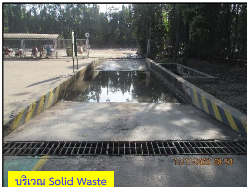
ภาพที่ 2.25 จุดล้างล้อรถบรรทุกขนส่ง Solid Waste และ Biomass
