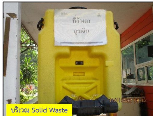
ภาพที่ 2.51 ฝักบัวฉุกเฉินและอ่างล้างตาฉุกเฉินภายในพื้นที่โครงการ
