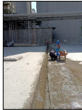
ภาพที่ 2.14 การล้างท่อและวางระบายน้ำในพื้นที่รอบๆ โครงการ
