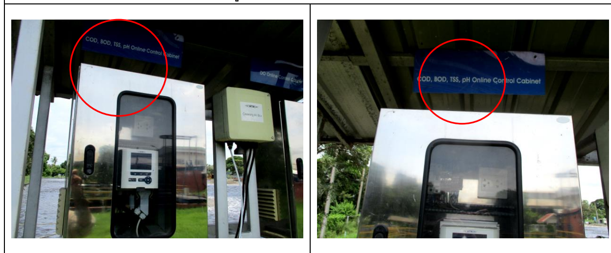
รูปที่ 9 อุปกรณ์ตรวจวัด COD Online บริเวณระบบบำบัดน้ำเสีย
