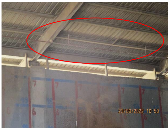
รูปที่ 46 ระบบสเปรย์น้ำได้หลังคาอาคารชีวมวล
