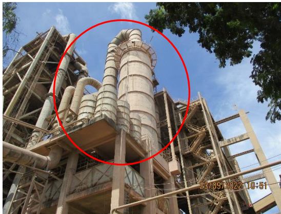
รูปที่ 7 Preheater Tower
