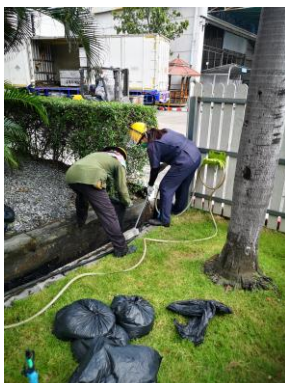
รูปที่ 12 การทำความสะอาดรางระบายน้ำ
