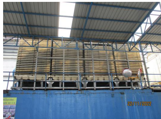
รูปที่ 11 หอระบายความร้อน (Cooling Tower)
