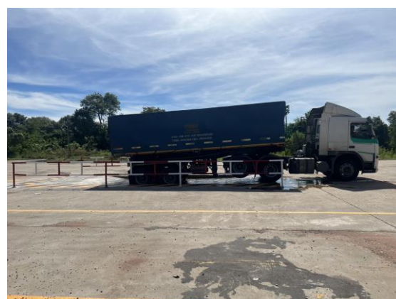
รูปที่ 16 พื้นที่ล้างล้อรถบรรทุกก่อนปล่อยออกนอกโครงการ
