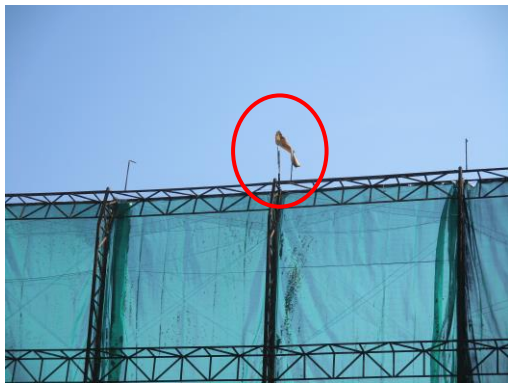
รูปที่ 11 การติดตั้งธงลมบอกทิศทางลม
