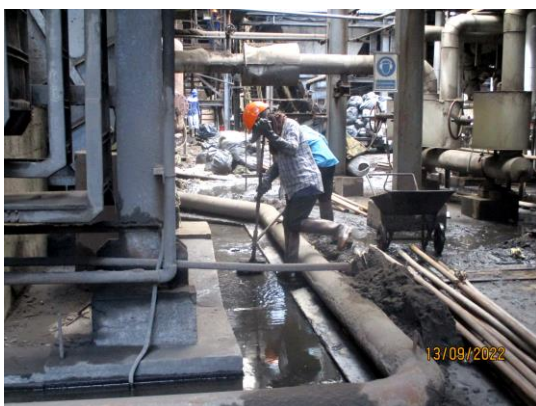
การทำความสะอาดรางระบายน้ำฝนของโครงการ
