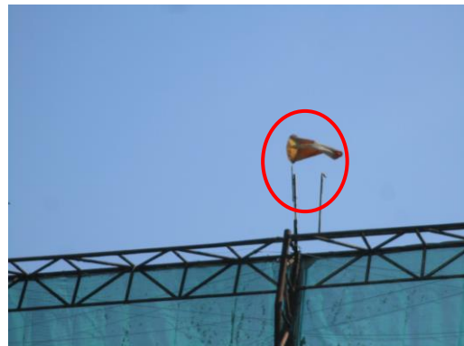
รูปที่ 11 การติดตั้งธงลมบอกทิศทางลม
